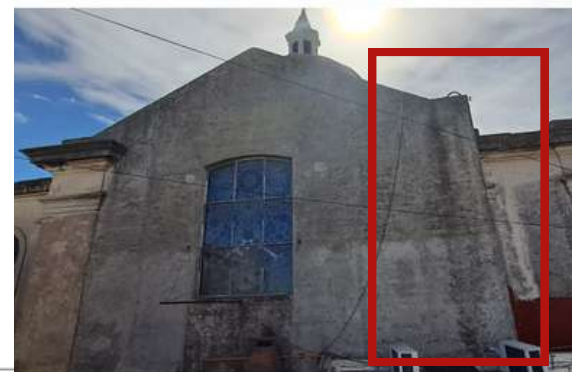
Ilustración N°36 Molduras faltantes
