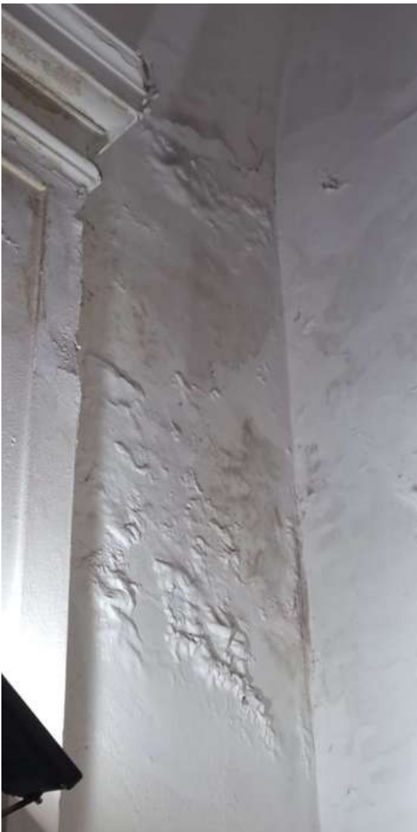
Ilustración N°50 y N°51 Deterioros en los revoques interiores
