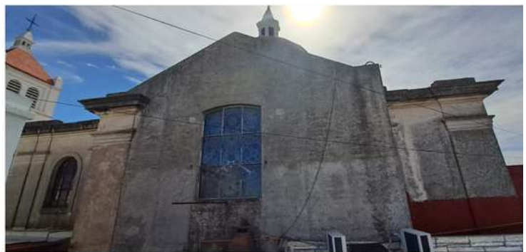
Ilustración N°55 Fachada lateral derecha
