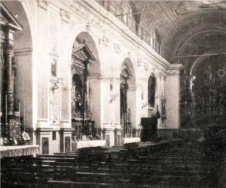
Ilustración N°13 Interior de la Iglesia San Nicolás de Bari antes de la demolición
