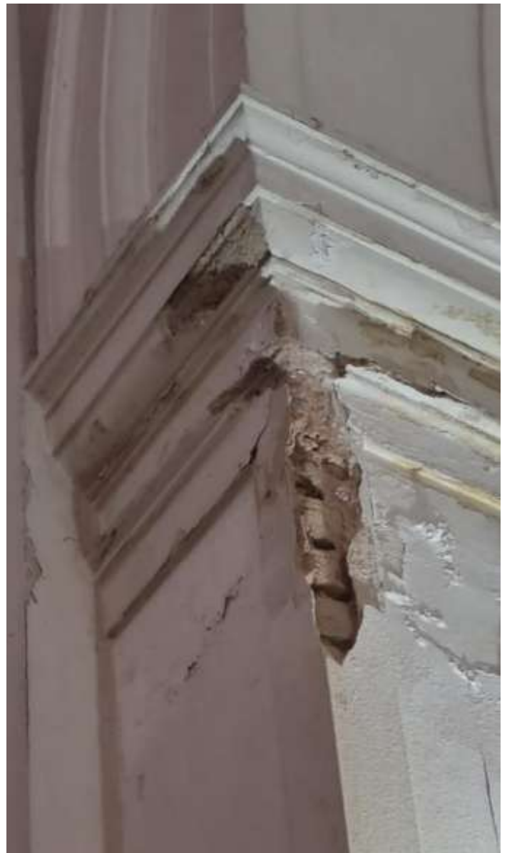
Ilustración N°50 y N°51 Deterioros en los revoques interiores
