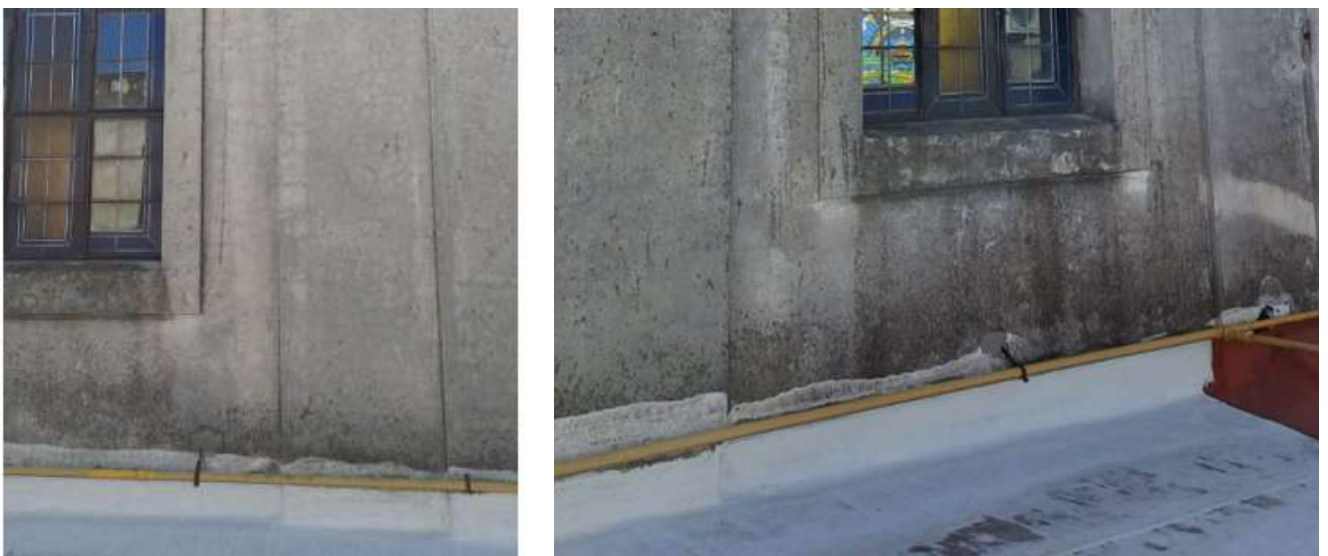
Ilustración N°48 y N°49 Unión de cubierta planta con los muros del templo
