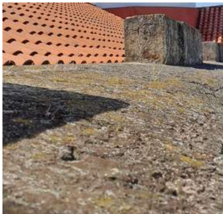
Ilustración N°54 Muros de carga
